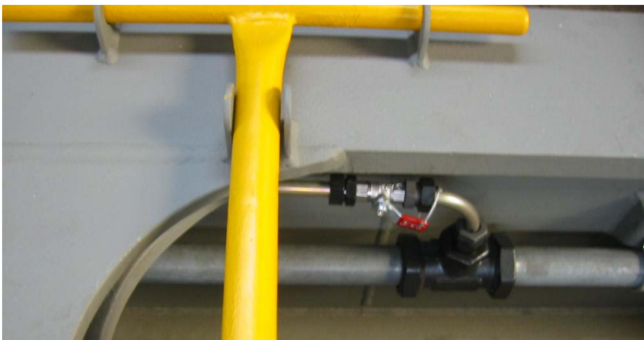
Bild 7: Notabsperrhahn (NAH)
